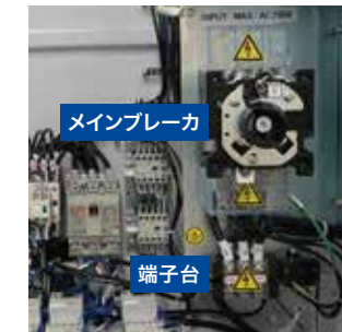
電源拡張 50A メインブレーカを30Aから50Aにアップします。関連する配線もサイズアップし、外部機器電源用にメインブレーカの下に端子台が付ききます。
